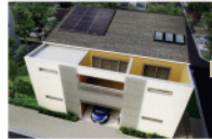
太陽光発電システム
