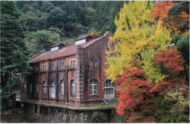
▲端出場水力発電所
