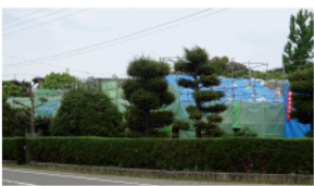
▲着工している銅山所長宅
