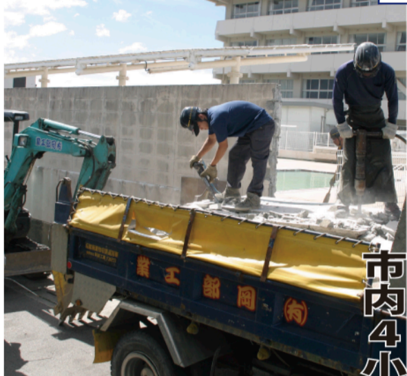
▲改修工事を行う垣生小学校
