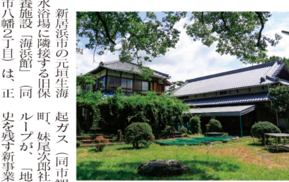
▲リノベーションが進む本館
