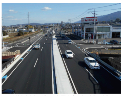
▲4車線化された国道11号新居浜バイパス萩生一大生院
