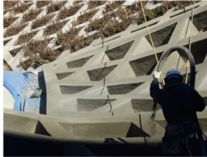
▲県内全域で法面保護工事を専門に展開
