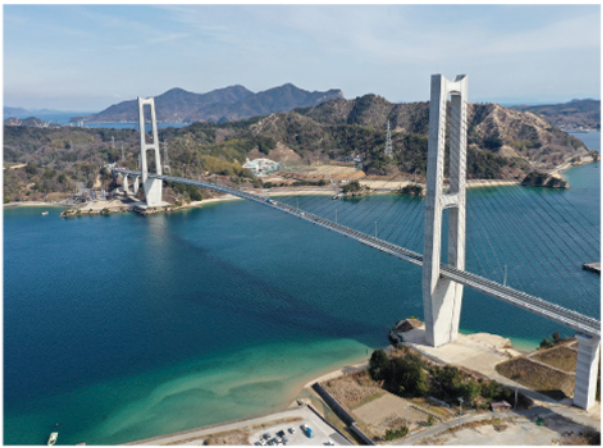
▲生名島から岩城島を結ぶ「岩城橋」が完成
