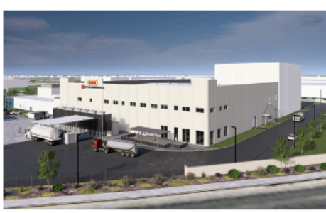
▲2028年2月に竣工予定の第二期棟のイメージ
